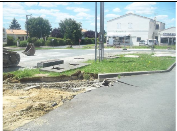
Vue zone parc à cuves/événements avant démantèlement
