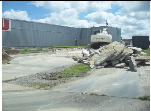
Zone d'entreposage revêtement de surface (enrobé et dalle béton)
