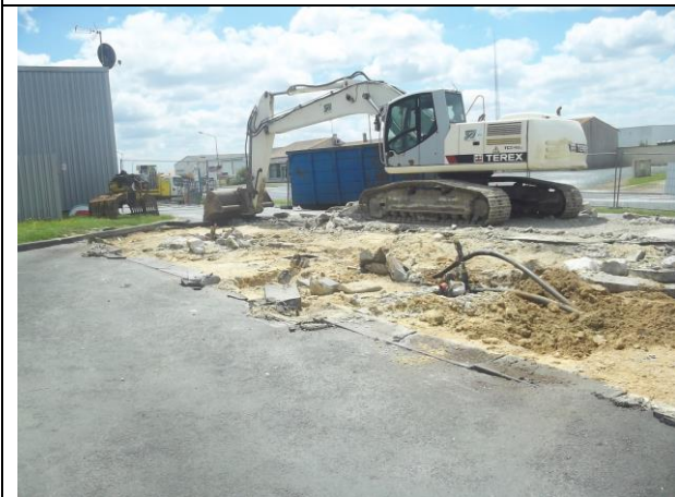
Zone de travaux auvent/pistes de distribution
