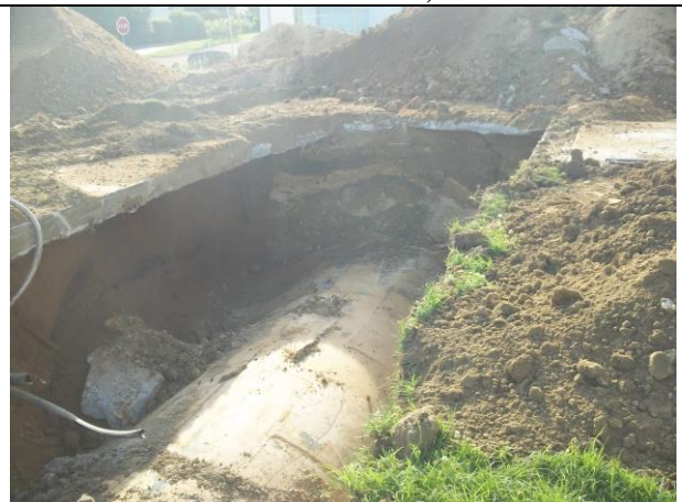
Fouille cuve 80 m 3
