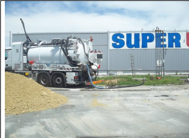
Hydrocurage des réservoirs
