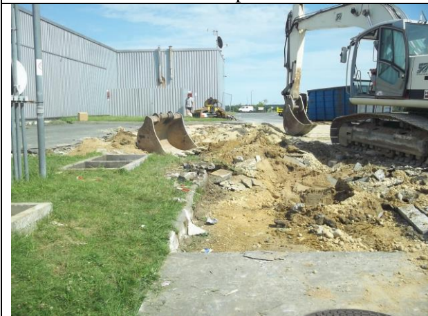
Vue zone de travaux séparateur
