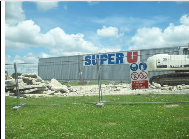
Vue zone de travaux station-service
